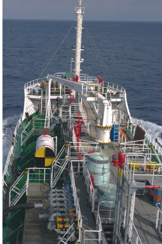
A#5 Tanques BT Isla Puná 1
