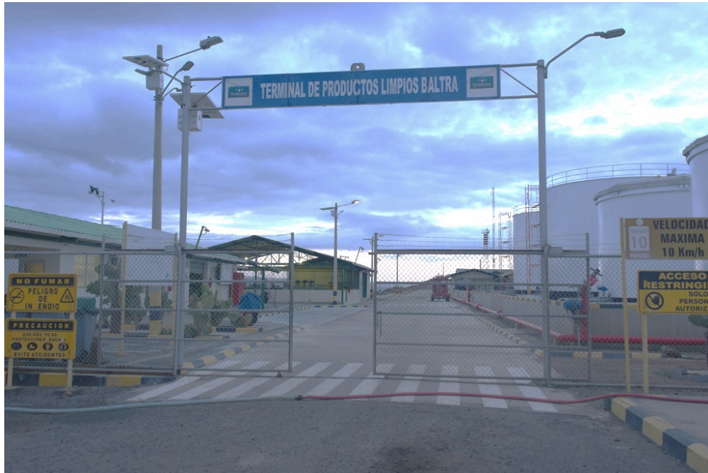
A# 21 Terminal de Productos Limpios Balt 1
