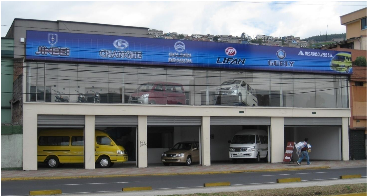
La fachada delantera en la Av. Pedro Vicente Maldonado
