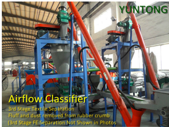
Figura N° 23: Fase 8 Extracción de polvo y pelusa.
