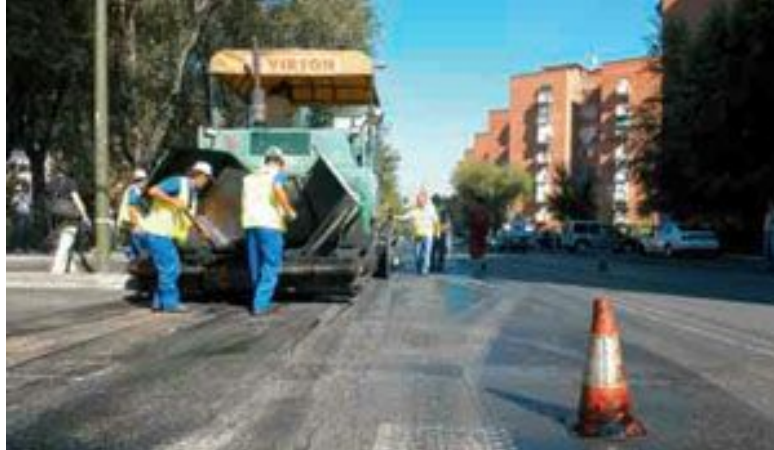
Figura N° 12: Aplicación de gránulo de caucho en asfalto.
