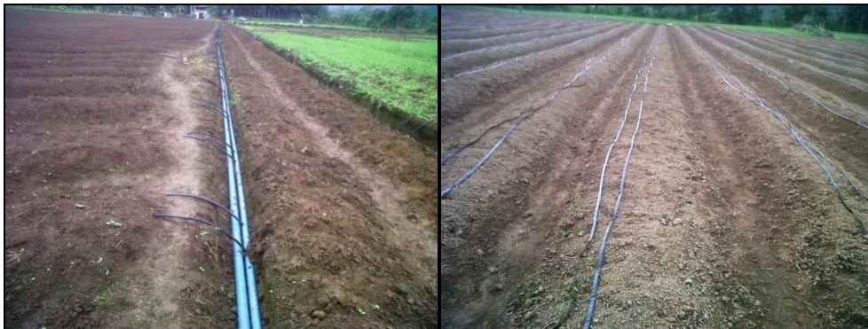
Imagen 11: Instalación del sistema de riego
